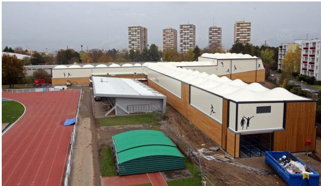
La nouvelle salle d'athlétisme est implantée sur le site du stade de l'Europe. La couverture du bâtiment, qui forme un grand "T", est assurée par une toile textile de couleur "champagne". Photos L'Alsace/Vanessa MEYER
